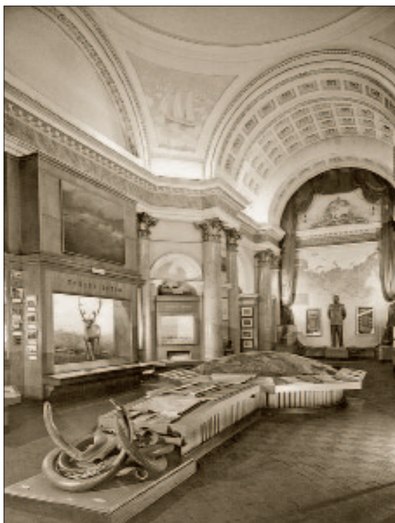
Вид центрального зала первого этажа музея. 1953
